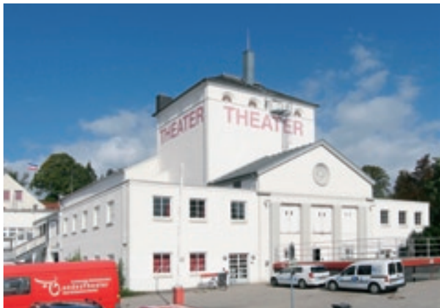
Im Juni vergangenen Jahres wurde der große Zuschauerraum des Schleswiger Theaters wegen akuter Einsturzgefahr des Daches gesperrt. Eine Nutzung der großen Bühne und des Zuschauerraumes ist in der Spielzeit 2011/2012 ausgeschlossen.
