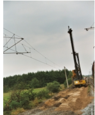
Sanierung der Bahnstrecke Flensburg - Neumünster - Quelle: MWAV (2003)
