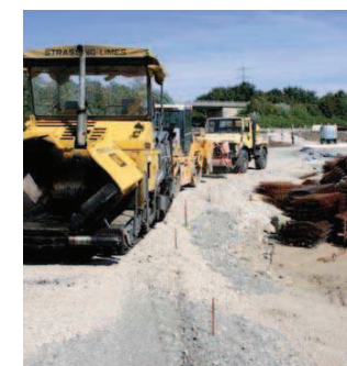
Naturzerstörungen bedürfen des flächigen Ausgleichs.
