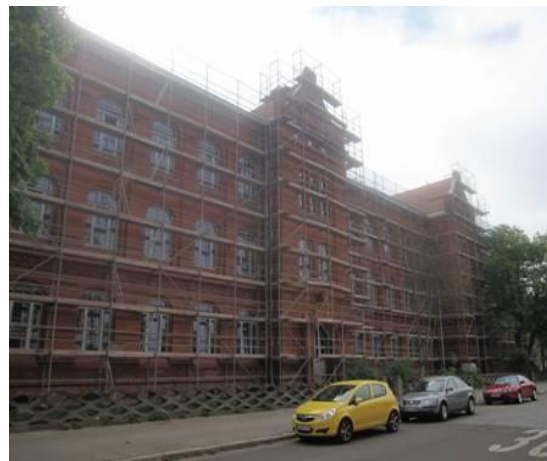
Bsp.: Werner v. Siemens Gymnasium Magdeburg
