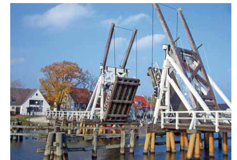
Der „Super-Poller“ an der Wiecker Klappbrücke in Greifswald macht weiter Ärger.
