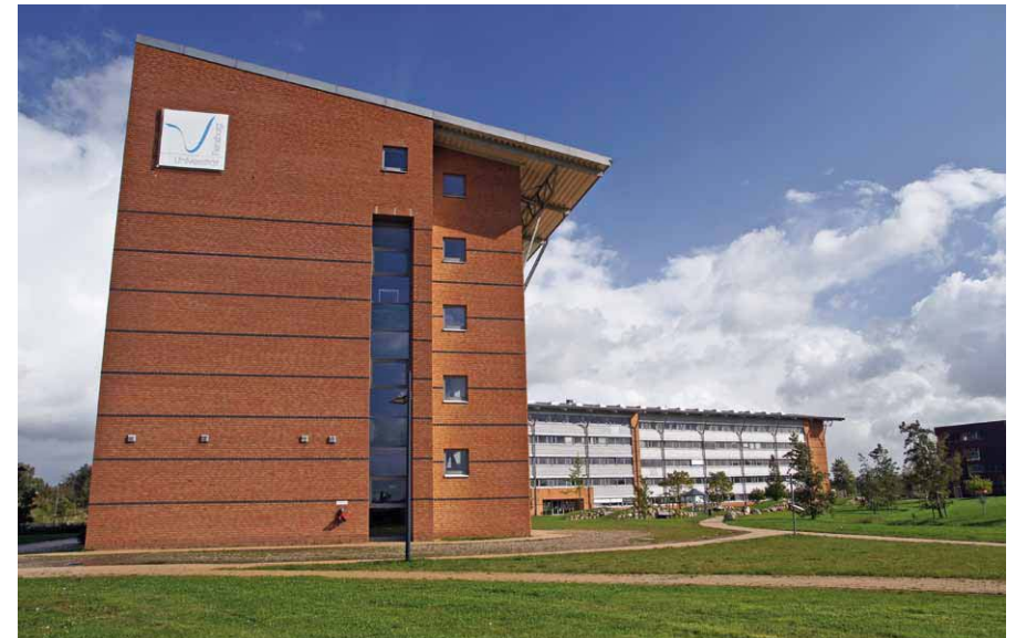
Der Orkan „Christian“ riss das Metalldach vom Hauptgebäude der Universität Flensburg, weil es beim Bau nicht ordnungsgemäß befestigt worden war.
