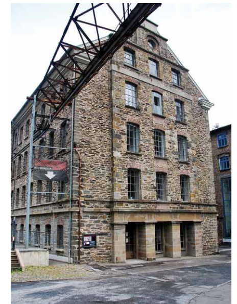
Die schlampige Arbeit der Bauverwaltung wirft Fragen nach Konsequenzen auf.
