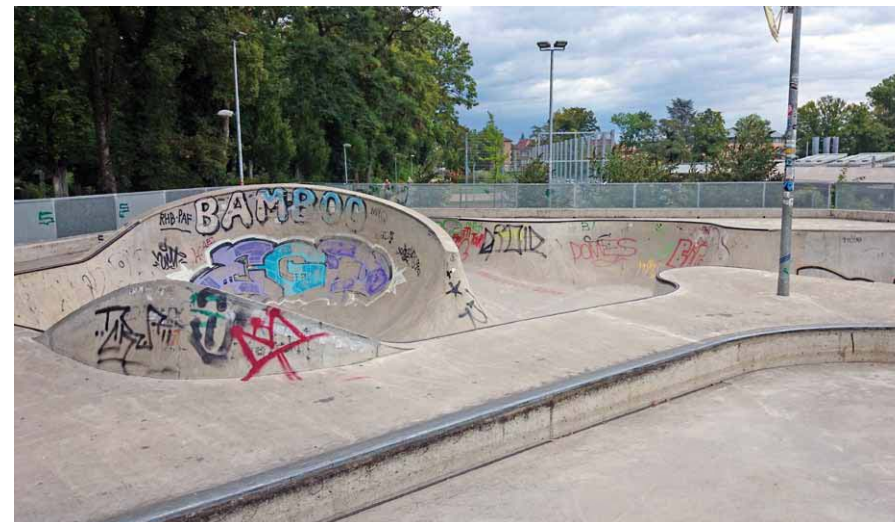
Teure Nachbesserung. Um die Anwohner einer Skater-Anlage in Stuttgart vor Lärm zu schützen, musste diese mit einer Kalthalle für rund 1,7 Mio. Euro überdacht werden.
