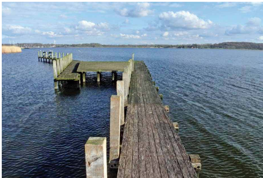
Schön sollen sie sein: Die Holzstege in der Schlei bei Schleswig. Doch nach fünf Jahren sind sie bereits so marode, dass die Bohlen ausgetauscht werden müssen.
