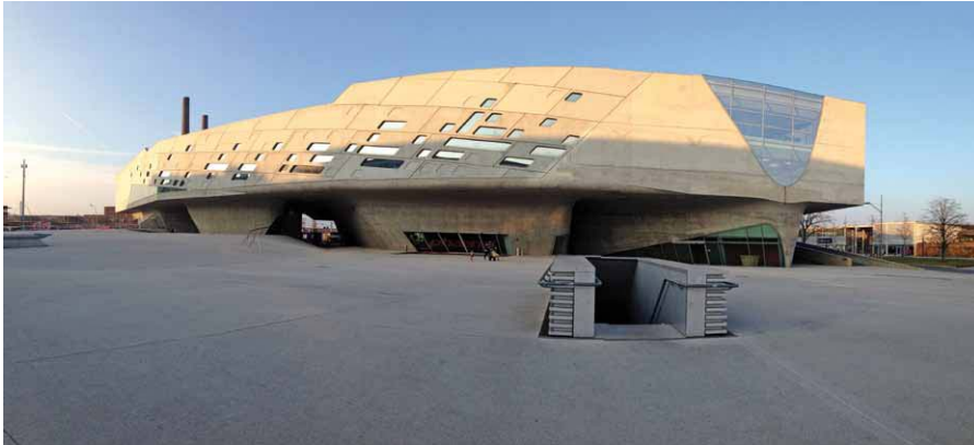
Auch bei den Außenanlagen des „Phaeno“ in Wolfsburg läuft nicht alles rund. Drei Sitzinseln aus Eichenholz sollten den Vorplatz verschönern, doch das Material macht Probleme.
