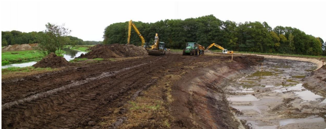
Abbildung 8: Baumaßnahme im Rahmen der Gewässerrenaturierung (Foto: Brunke, LLUR)
