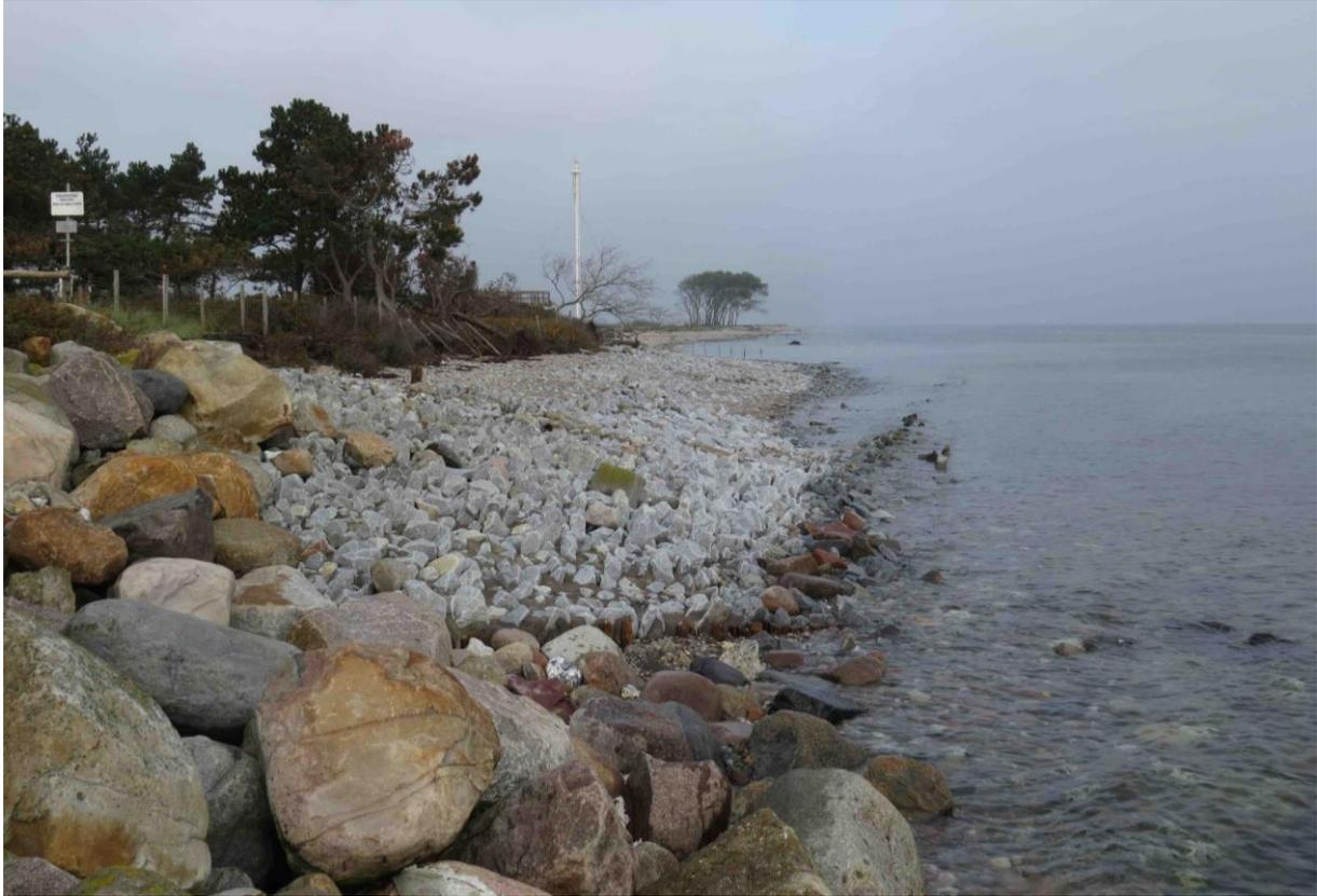
*Abb. 4: Mit Beton verklammertes Steindeckwerk nördlich der Strandmauer*
