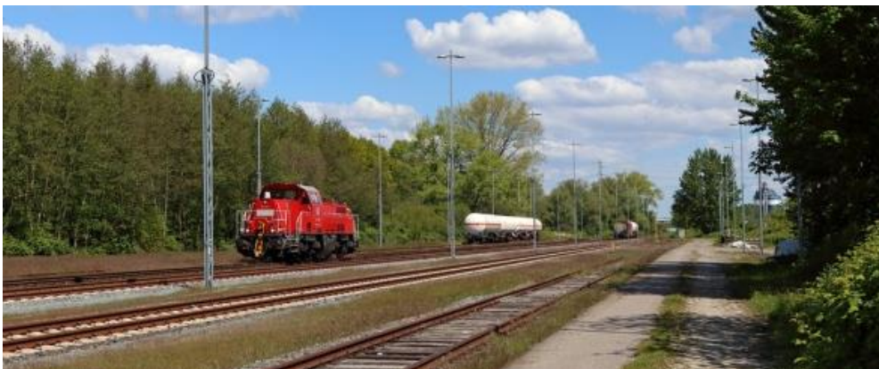
Abb. 2.3-9 Bahnhof Brunsbüttel (Foto: büro stadVerkehr)
