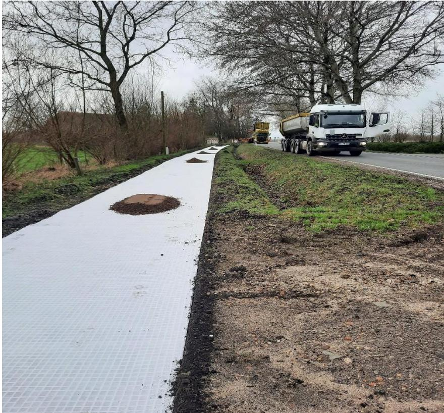
Radweg an der Landesstraße 212 zwischen Leck und Medelby, Geotextil auf dem Unterbau vor Aufbringen der Asphalt-Deckschicht – Foto: LBV SH
