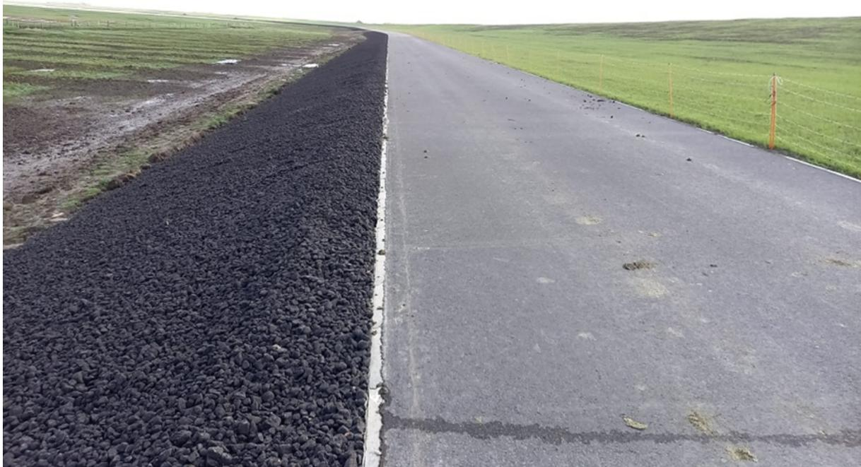
Deckwerk mit Wellenüberschlagssicherung, Föhr Toftum/Ackerum - Foto: LKN.SH
