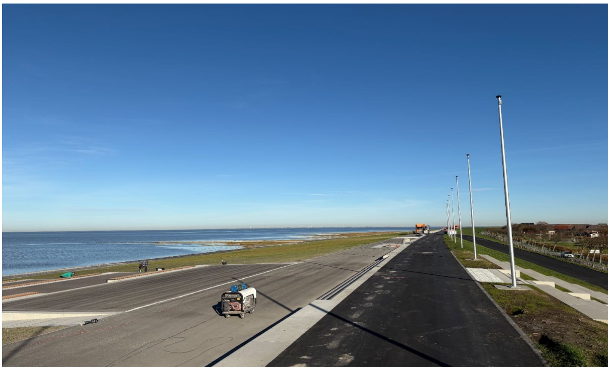
Deichverstärkungsmaßnahme Friedrichskoog Spitze – Foto: MEKUN
