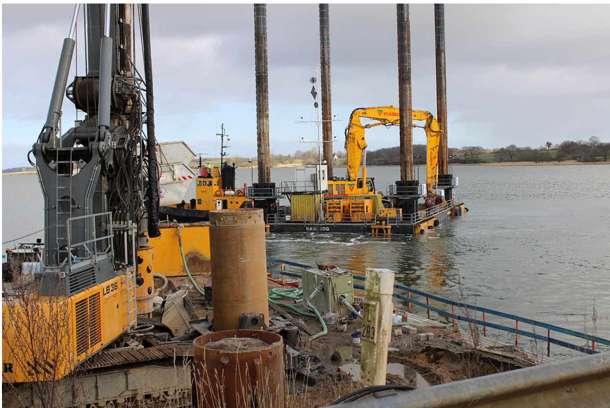
Neubau der Brücke Lindaunis – Foto: LBV.SH
