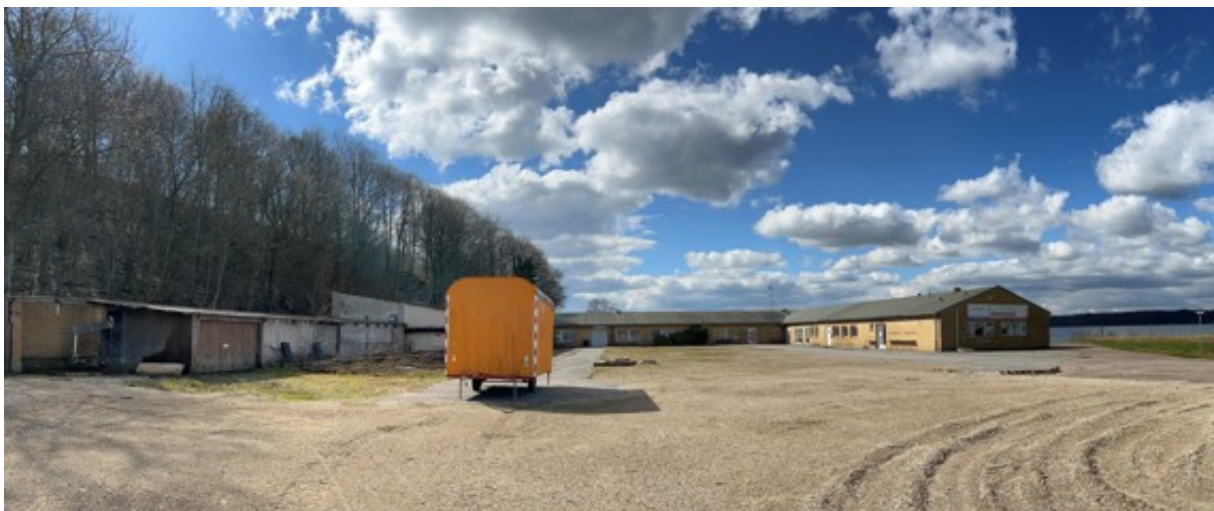
Brachliegende Fläche im Bereich Fahrensodde 20 in Flensburg vor Rückbau- und Sanierungsarbeiten – Foto: MEKUN
