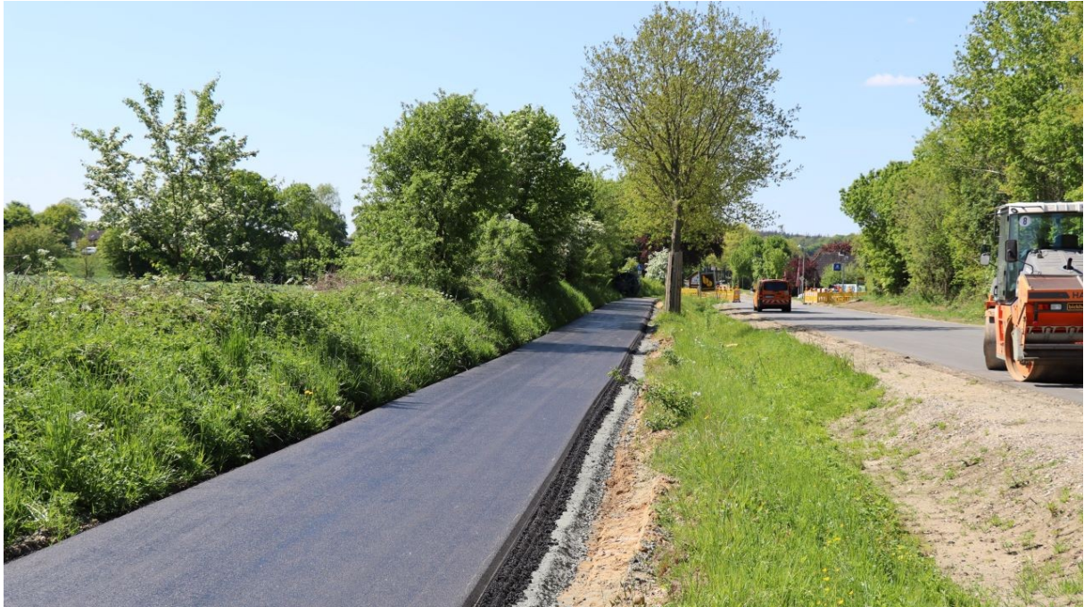
L125 - Straßenbau mit begleitendem Radwegebau – Foto: LBV.SH
