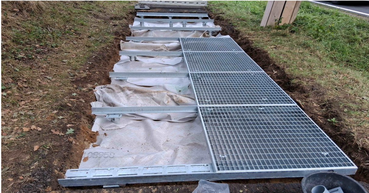
Einbau von Wurzelbrücken zur Vorbeugung von Wurzelaufrüchen im Radwegbau - Foto: LBV.SH
