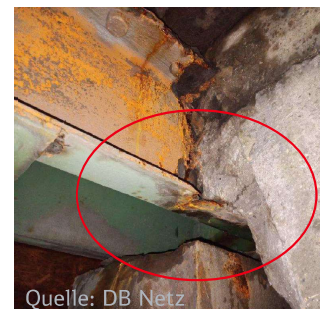
Durch Durchrostung eingerissene Träger im Übergangsbereich Tragkonstruktion und Beton, Sanierung sehr schwierig, da Sanierungsbereich in den letzten Jahren überbaut wurde
