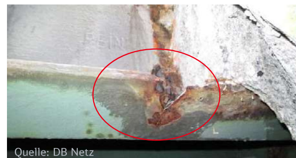
Durch Durchrostung eingerissene Träger im Übergangsbereich Tragkonstruktion und Beton, Sanierung sehr schwierig, da Sanierungsbereich in den letzten Jahren überbaut wurde
