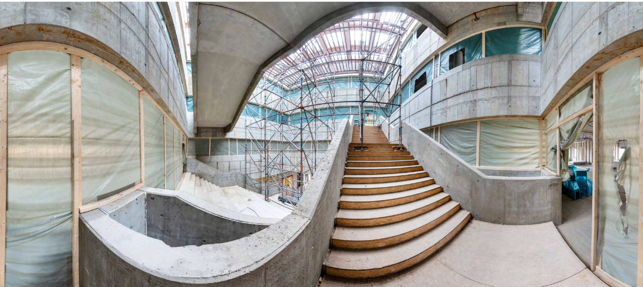
Abbildung 12: Baustelle Bibliothekearisches Lernzentrum, Treppenhaus, Panoramafoto
