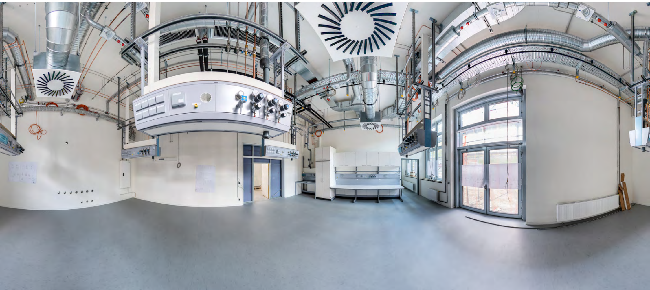
Abbildung 11: Baustelle ZEVS, Labor, Panoramafoto
