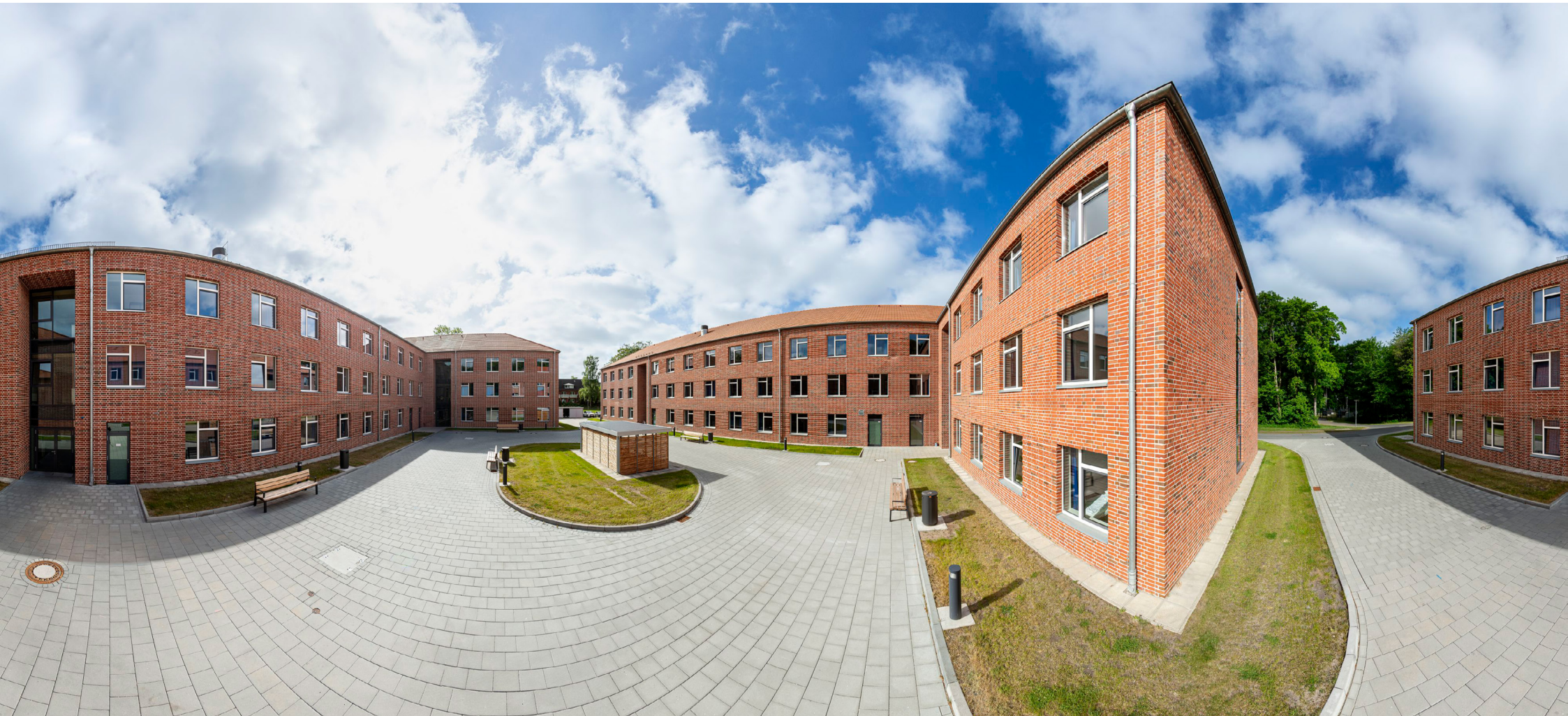
Abbildung 18: Marineschule Mürwik in Flensburg, Neubau von zwei Unterakunftsgebäuden | 360° Panoramafoto
