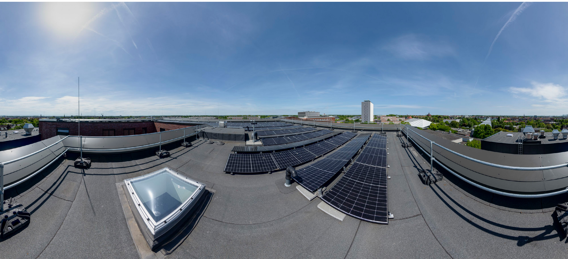
Abbildung 15: Christian-Albrechts-Universität zu Kiel, Neubau Agrar- und Ernährungswissenschaftliche Fakultät mit Photovoltaikanlage | 360° Panoramafoto
