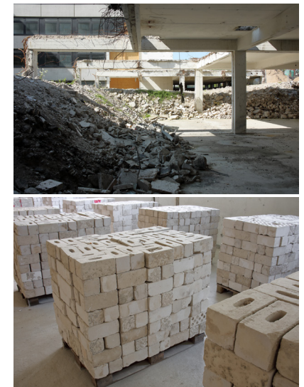
Abbildung 2: CAU, ressourcenschonende Sanierung der Fakultätenblöcke mit Urban Mining
