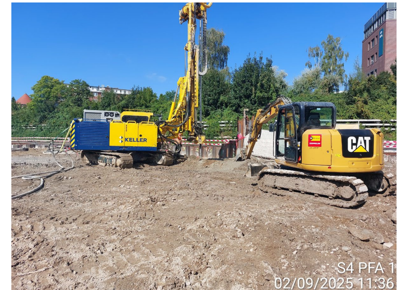
September 2025: DSV-Arbeiten (DSV – Düsenstrahlverfahren)
