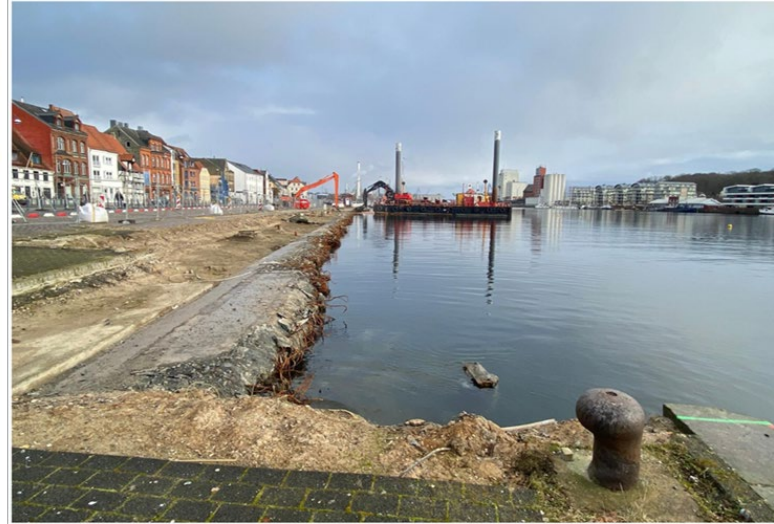
Abbildung: Rückbau der Kaiplatte
