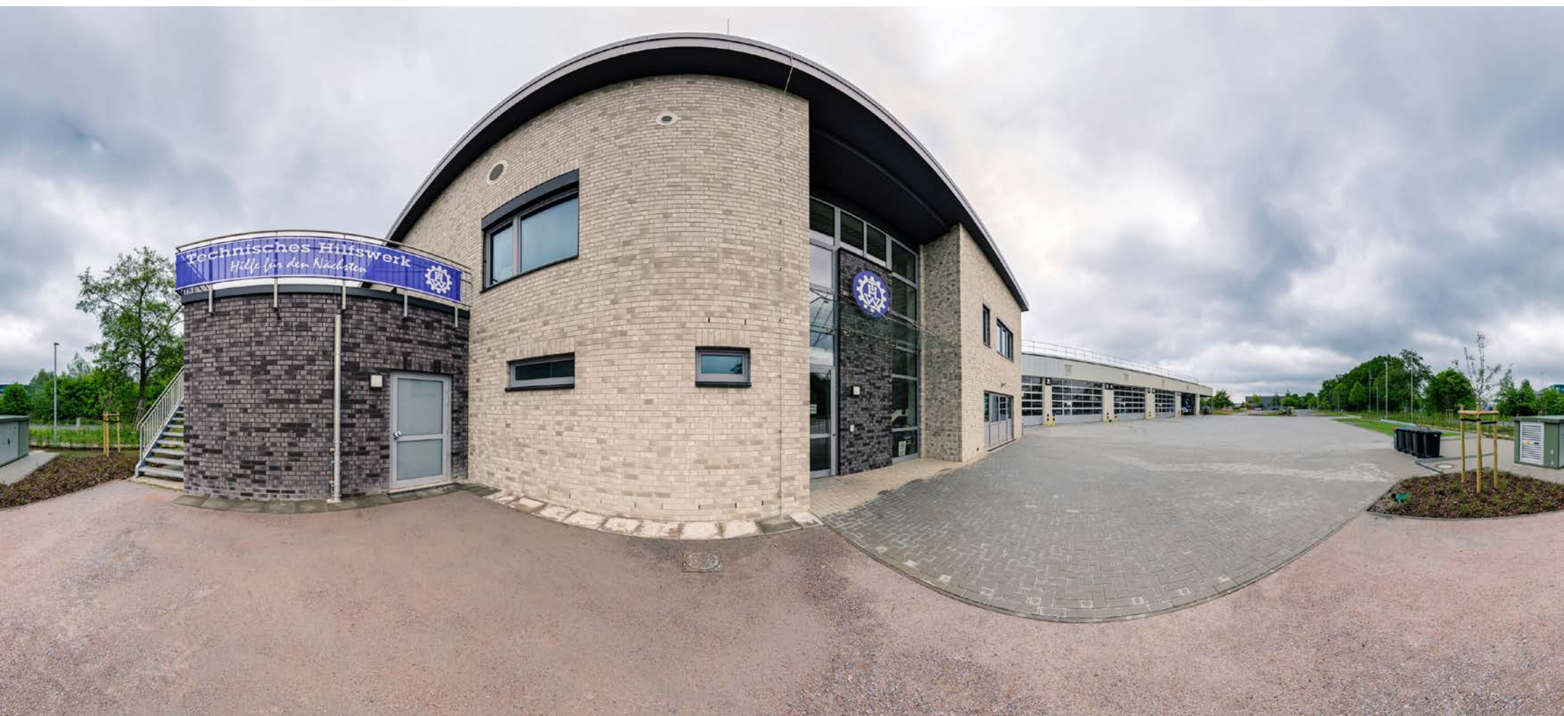
Abbildung 20: Technisches Hilfswerk (THW Kaltenkirchen), Neubau Ortsverbandsgebäude | 360° Panoramafoto
