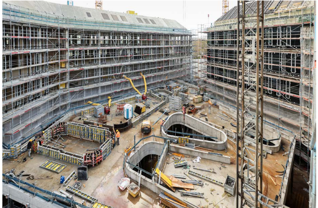
Abbildung 6: Größte Baustelle: In nur einem Jahr sind die Rohbauten vom Hugo Salomon Forschungszentrum und vom Braak Forschungszentrum für Integrative Systemmedizin (ZISMed) für die Christian-Albrechts-Universität zu Kiel entstanden.
