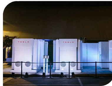
Großspeicher (Strom / Wärme)
