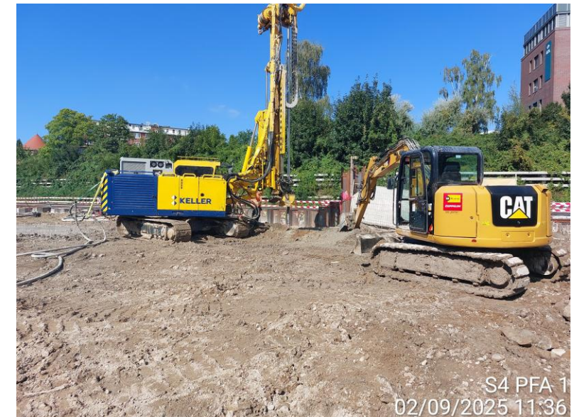
September 2025: DSV-Arbeiten (DSV – Düsenstrahlverfahren)
