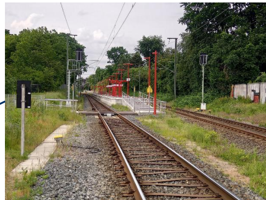
Bahnsteig Schnelsen Süd nach baulicher Fertigstellung
