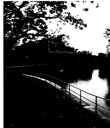
Saniertes Gebiet am Binnenhafen in Friedrichsstadt
