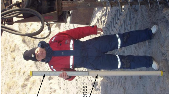
„Druckausgleichsrohr (PEM)“ vor dem Einrammen in den Strand
