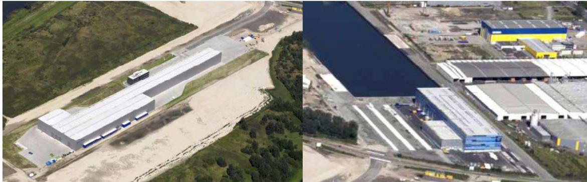
Abb. 2: Links: Produktionshalle PowerBlades GmbH in Bremerhaven; Rechts: Gondel- und Nabenproduktion der REpower Systems AG in Bremerhaven. Quelle: LSA 2009.
