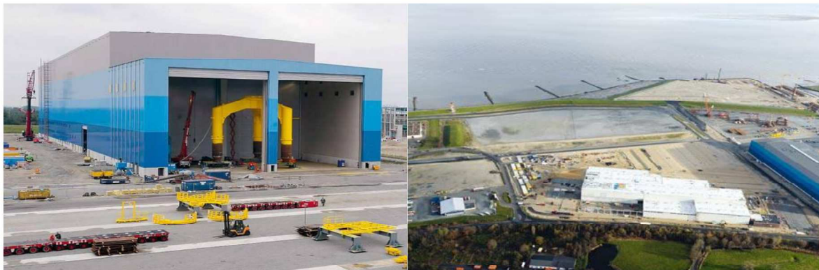
Abb. 3: Links: Produktionshalle Cuxhaven Steel Construction GmbH in Cuxhaven; Rechts: Turmproduktion der Ambau GmbH in Cuxhaven. Quelle: LSA 2009.
