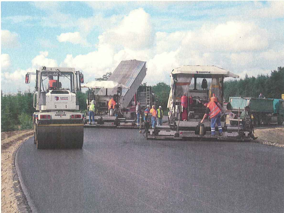
Einbau einer neuen Fahrbahn
